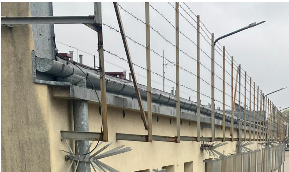
Fot.2 Budynek zakwaterowania — korozja elementów stalowych
