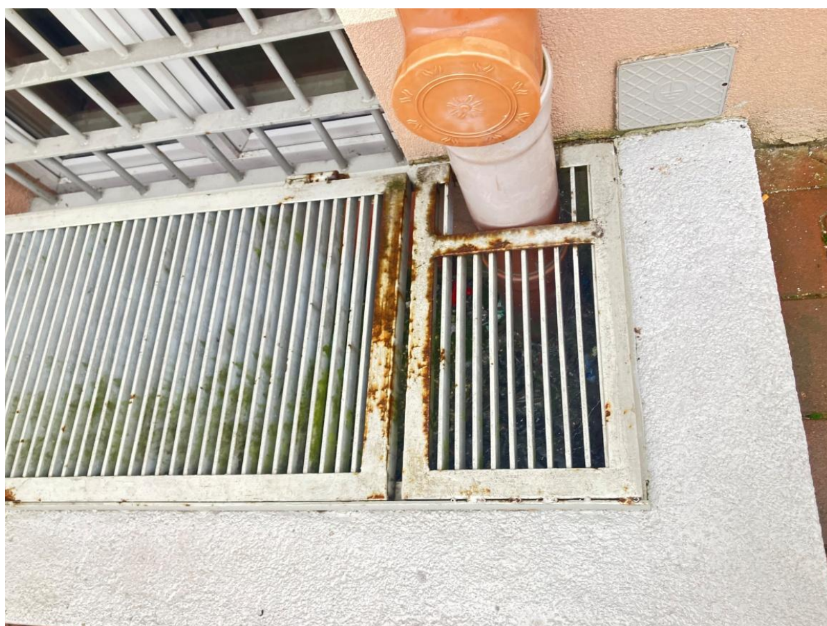
Fot.3 Budynek zakwaterowania — ogniska korozji na kratkach doświetla piwnic
